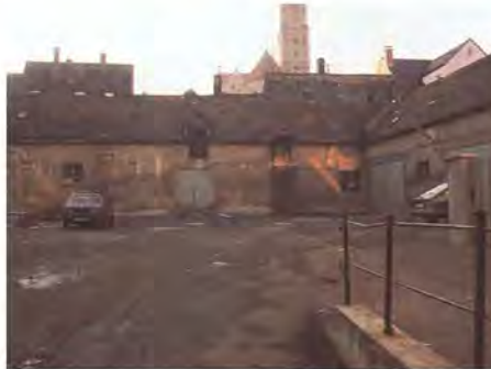
Innenhof hinter Spitalgasse 14 mit dem sanierten und ausgebauten Stadel
