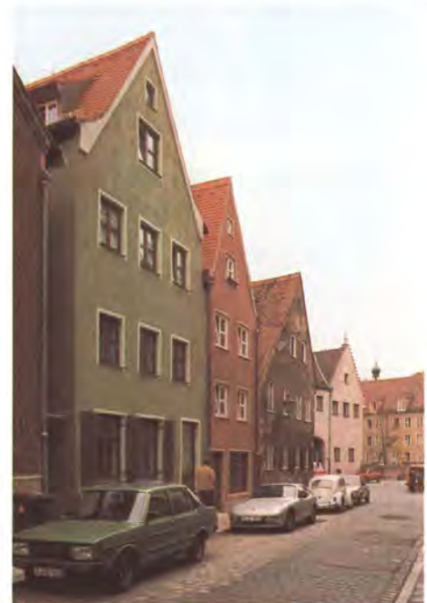
Die zwei schmalen Wohnhäuser Kirchgasse 19 und 21
