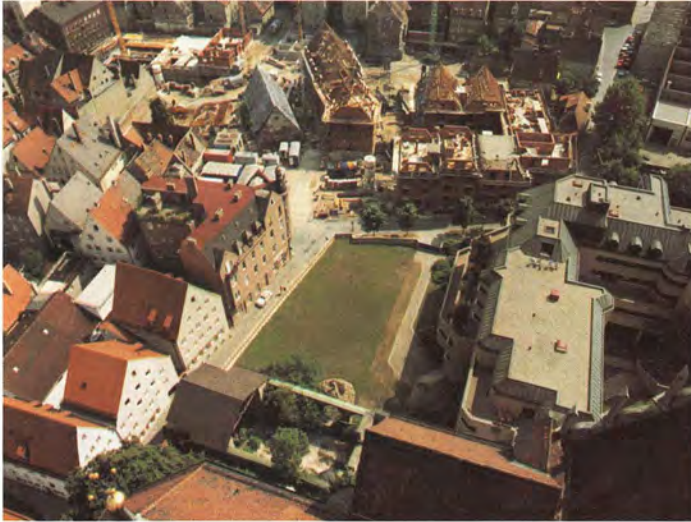
Blick vom Ulrich auf die Häuser an der Peter-Kötzer-Gasse und die Baustelle
