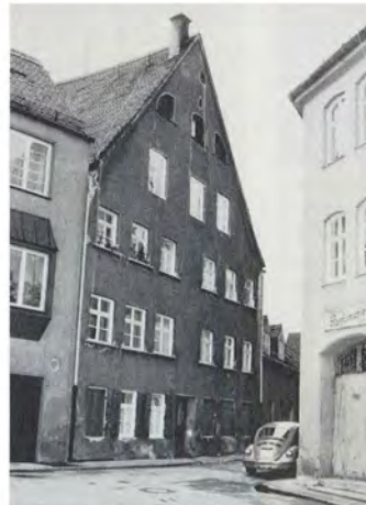
Wohnhaus und Innenhof Hinterer Lech 12
