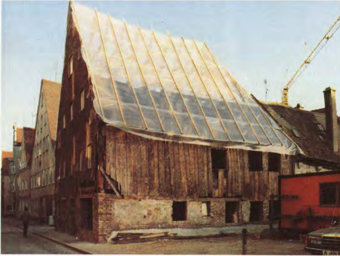
Die kleine Gebäudegruppe Kirchgasse 8 mit spätgotischen Bauteilen wird sorgfältig saniert
